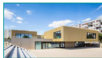
Espace culturel et centre social, Nemours – Technal © Photographe S. Grazia Découvrir la référence chantier
