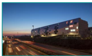
Éco-quartier de Fresnes – Technal © Photographe Hervé Abbadie Découvrir la référence chantier
