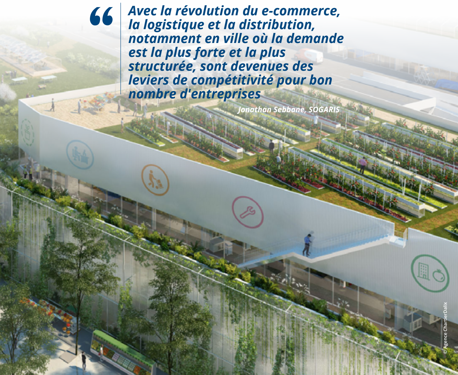
Hôtel logistique SOGARIS, ZAC Gare des Ardoines (Vitry-sur-Seine) par l'agence Chartier-Dalix
